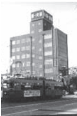
昭和51年（1976） 第一交業株式会社 本社社屋落成
